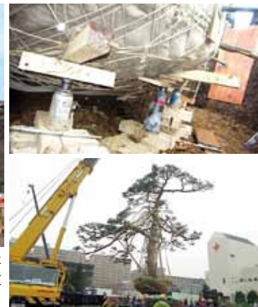
アカマツ(推定樹齢300年)の移植。(写真左上)2004年、移植前の写真。(写真右上)2007年移植開始。油圧ジャッキで根鉢を支える。(写真右下)移植開始。(写真下)移動中の様子。
