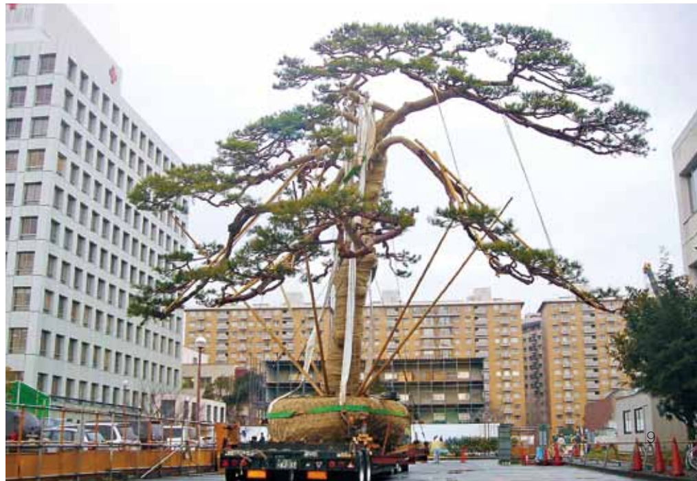
アカマツ(推定樹齢300年)の移植。(写真左上)2004年、移植前の写真。(写真右上)2007年移植開始。油圧ジャッキで根鉢を支える。(写真右下)移植開始。(写真下)移動中の様子。
