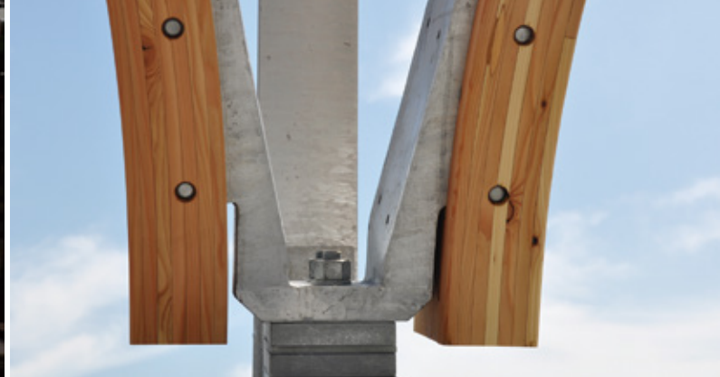
(左上) 湾曲材を構成する挽き板は7枚積層。1つの治具で4本制作可能な工夫を行った。(左下) 菱形の形成に2本の湾曲集成材を使うことで接合部を2箇所減らすメリットがある。(中央) 接合部。側面に2枚の羽プレートが突き出した形状。
