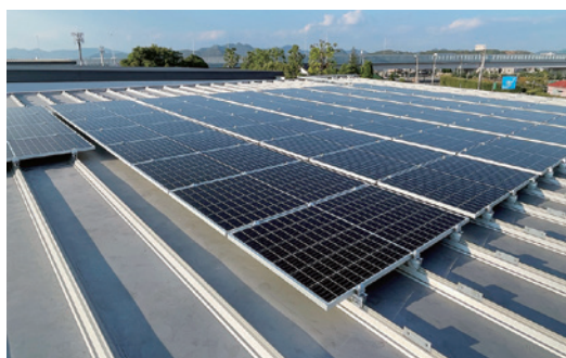
太陽光パネル設置風景
